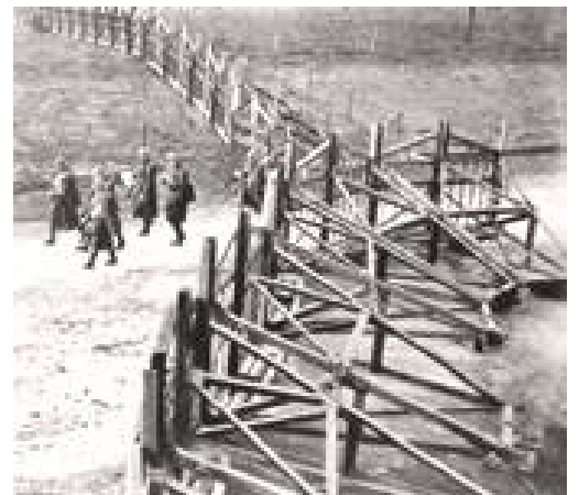
La ligne KW. Cette photo montre comment les barrières « Cointet » s'accrochaient l'une à l'autre.
