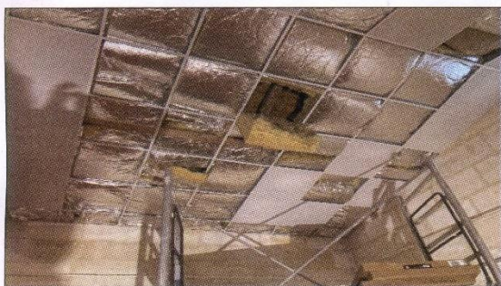
Isolation plus pose de dalles neuves au plafond par les agents du service technique
