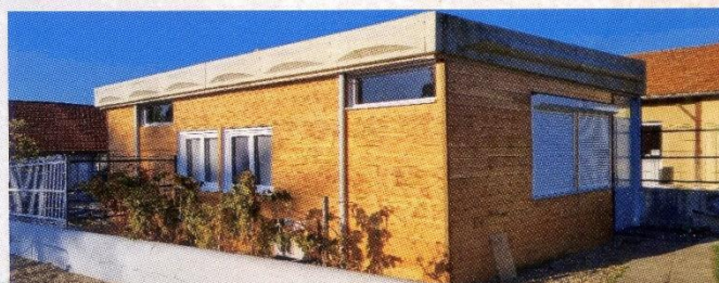
Renovation salle des Associations
