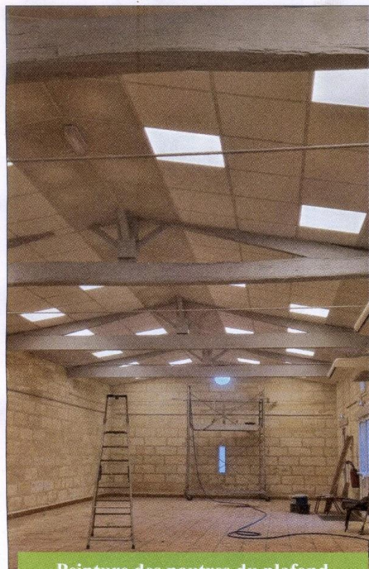
Peinture des poutres du plafond par les agents du service technique
