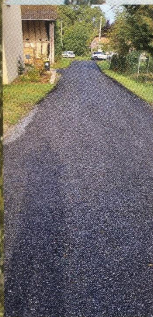
Réfection impasse Corbineau
