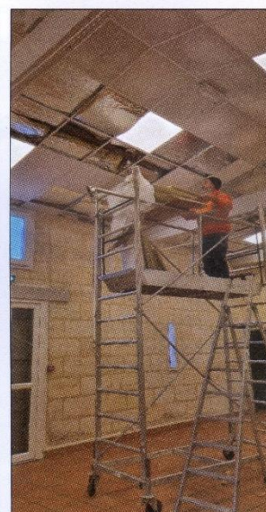
Réfection électricité et pose de leds par un professionnel
