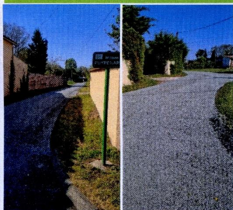
Rénovation Impasse Puyrenard /Impasse Pichot
