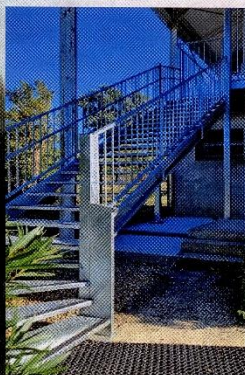
Changement Escalier garderie
