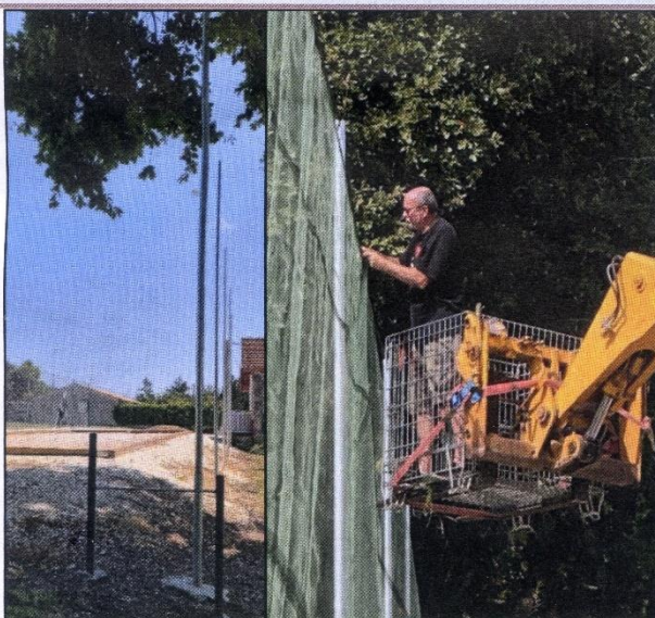
Création et mise en place d'un filet protecteur au city stade
